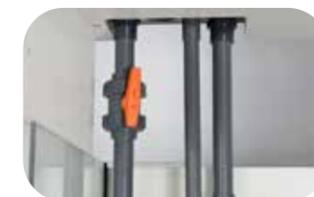
Tubazioni preassemblate: Tubazioni fisse in PVC-U; tubo in silicone come raccordo alla pompa di alimentazione (sistema plug & play)
